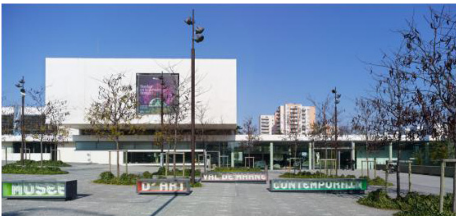
La façade sud du MAC/VAL. Photo © Luc Boegly.
