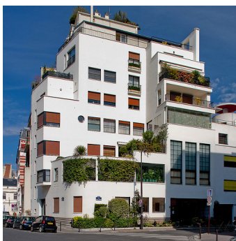
Hôtel particulier construit par Robert Mallet-Stevens, à Paris (16 e arrondissement) 1926-1927. Photo © D.R.
