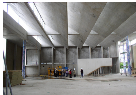
Les sheds inclinés de la salle des expositions temporaires. Photo © MAC/VAL.
