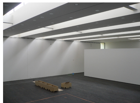
Les canaux de lumière de la grande salle. Photo © MAC/VAL.
