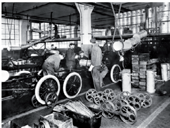
Chaîne de montage : assemblage d'une Ford TI dans une usine Ford Motor Company en 1913.
